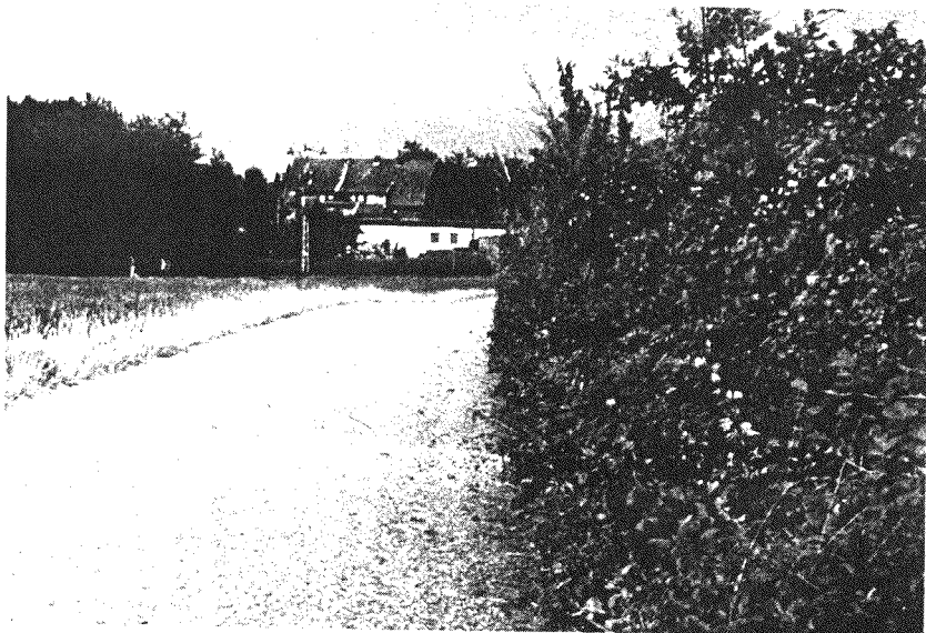
Der neue Rad- / Fußweg entlang der L47 vor dem Ortseingang Rimbürg
